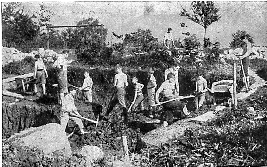
Angewandter Sport: Erdaushub für ein Schwimmbad (Landerziehungsheim Hof Oberkirch bei Kaltbrunn)
