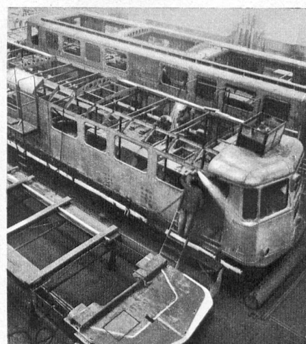
Lokomotivkasten im Rohbau
