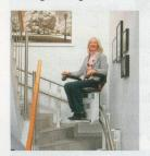
Ein kurvenfähiger Sitzlift lässt sich in jedes Treppenhaus einpassen rade Treppen bis zum anspruchsvollen Sitzlift für Wendeltreppen. Auch unterschiedliche Steigungen, partielle Waagerechtfahrten und mehrere Etagen sind kein Hindernis. Bei Kurvenliften gewährleisten Doppelrohrführungen aus Edelstahl unübertroffene Kurvenstabilität und besten Fahrkomfort, die von Einrohrführungen niemals erreicht werden. Der patentierte Traktionsantrieb kommt sowohl für Sitz-
