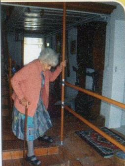
Zu den kleinen Hilfen gehört im Flur ein **Handlauf** an der Wand, sichere **Griffe im Bad und WC**, evtl. eine senkrechte **Haltestange** neben dem Bett und vor allem an der Treppe den Handlauf an der „richtigen“ Seite. Wichtig ist, dass der Handlauf an der Wandseite
