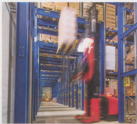
Entrepôt à étagères élevées, avec 6500 emplacements pour palettes
