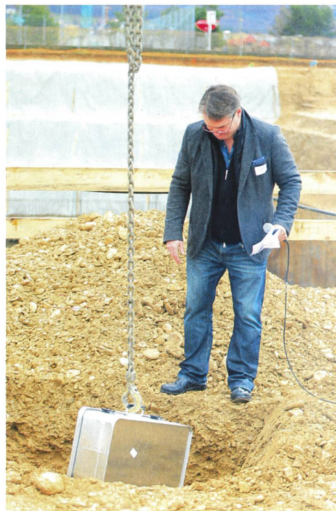
Präzise versenkt ein Kranführer den Metallkoffer in der vorgesehenen Erdgrube.
