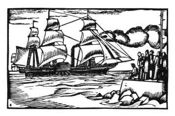
Dies war das erste Dampfschiff, welches den Ozean überquerte. Es hiess «Savannah» und fuhr 1819 in 26 Tagen von Nordamerika nach Liverpool. Bei günstigem Wind benützte sie noch die Segel, weil das Schiff nur für 18 Tage Brennmaterial (Fichtenholz) mitnehmen konnte.
