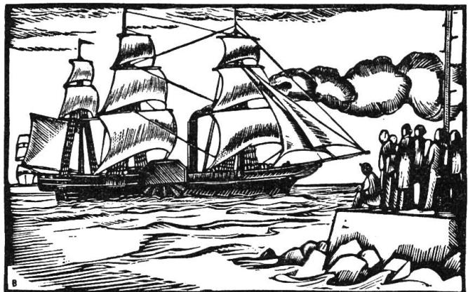
Dies war das erste Dampfschiff, welches den Ozean überquerte. Es hieß «Savannah» und fuhr 1819 in 26 Tagen von Nordamerika nach Liverpool. Bei günstigem Wind benützte sie noch die Segel, weil das Schiff nur für 18 Tage Brennmaterial (Fichtenholz) mitnehmen konnte.
