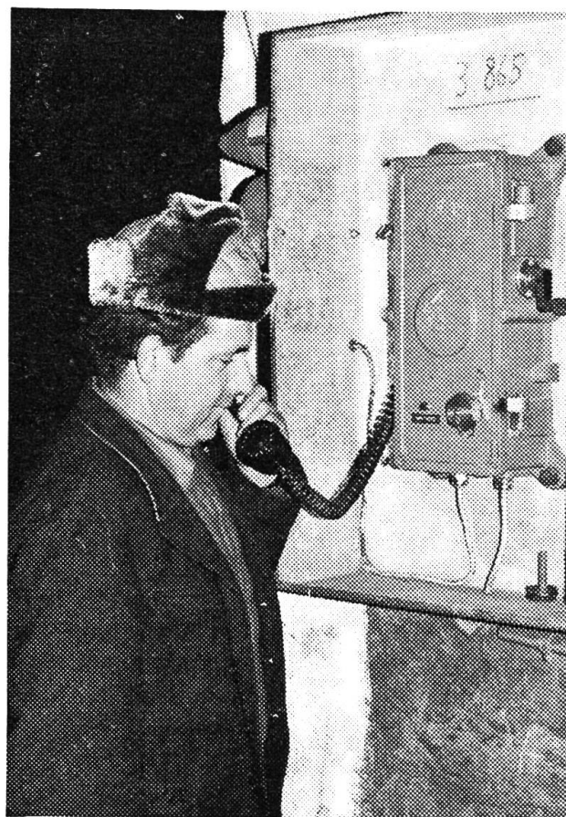
Bei den Signalen und Weichen im Tunnel, ausserdem in Abständen von einem Kilometer, befindet sich in einer grossen Nische ein Telefon. Hier erkundigt sich Streckenwärter Paul Grunder nach einem gesperrten Geleiseabschnitt.
