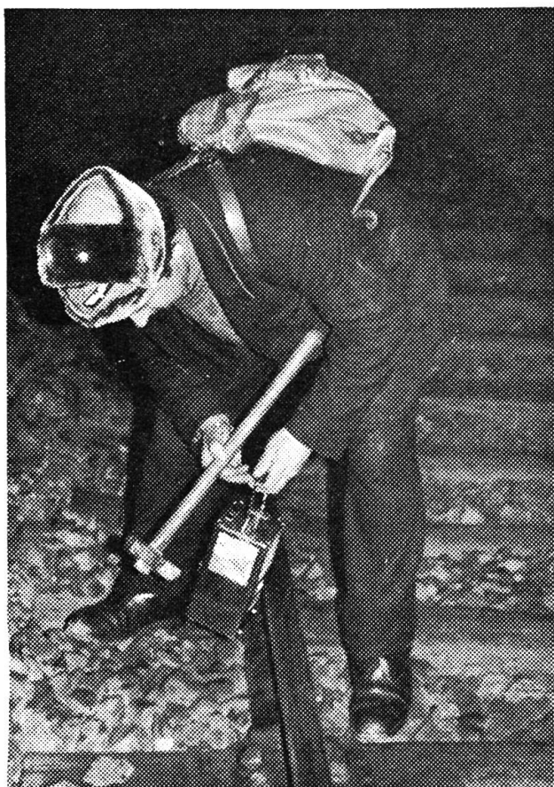
Ist alles in Ordnung? Aufmerksam prüft hier der Streckenwärter eine Schweissnaht: Beim Vorüberfahren eines Zuges gab es hier ein verdächtiges Geräusch.
