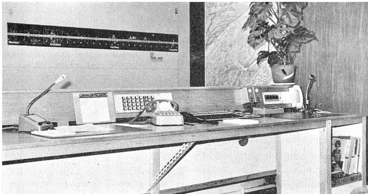
Blick in das Büro der Notrufzentrale Bern. Im Vordergrund befindet sich die Sprechfunkanlage. Im Hintergrund an der Wand ist ein Schema der Autobahn mit 28 Kontrolllämpchen. Sie ent-
