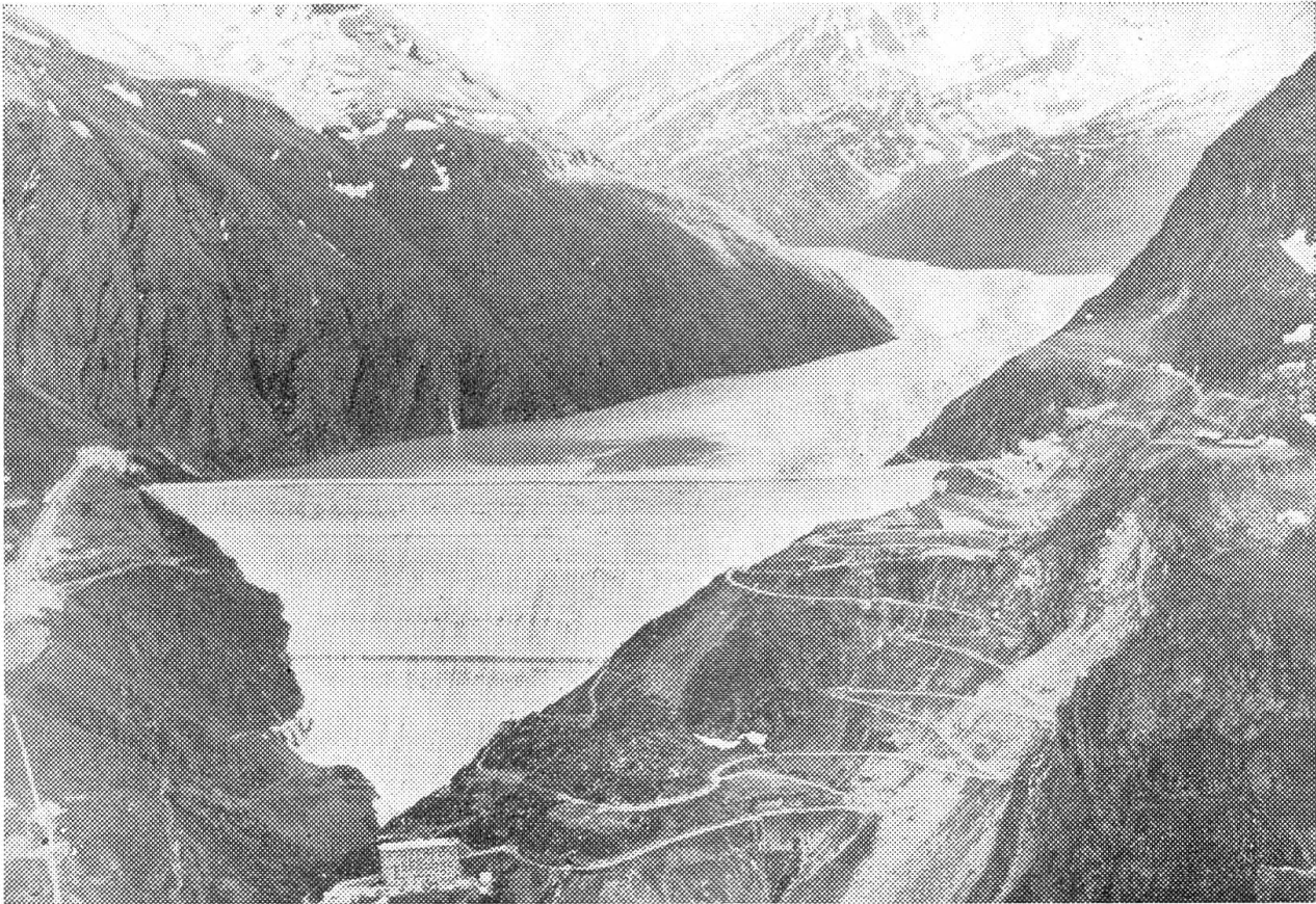
Flugaufnahme von der imposanten Staumauer
