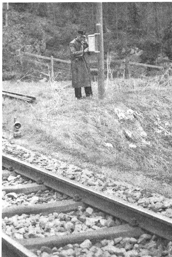
Dringende Meldungen erstattet der Streckenwärter durch Diensttelefone an der Strecke.
