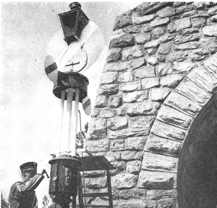
Die alten Signale müssen täglich von Hand aufgezogen werden.
