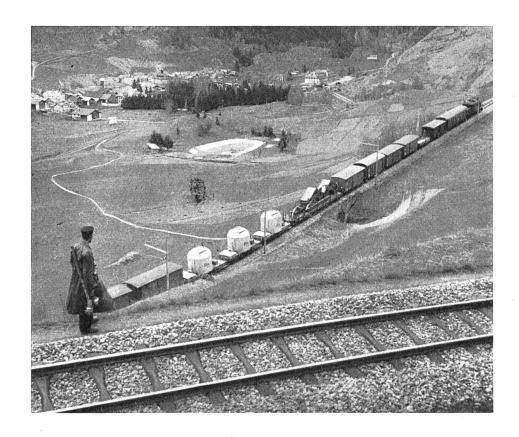
Bild 2 Oberhalb Bergün/Bravuogn gewinnt die Albulabahn in weiten Kehrschleifen die nötige Höhe.
