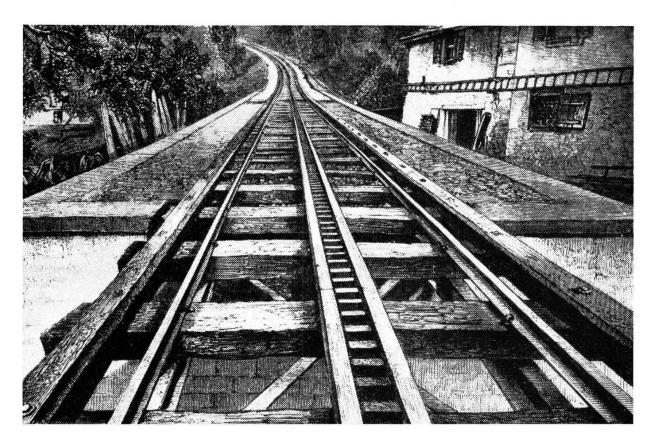
Bahngeleise der Rigibahn mit der Zahnstange, die seit Riggenbach nie ausgewechselt wurde. Diese Zahnstange ist also über 80 Jahre alt und immer noch gut.
