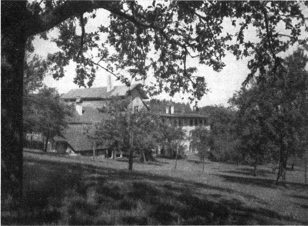
Ansicht des Heims von Osten.
