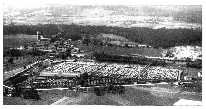
Fliegeraufnahme der Zellulosefabrik Attisholz A.-G. Im Vordergrund: Holzlager. — Links oben: Flüssigkeits- (Lauge-) Turm. Dieses Bild wurde uns in freundlicher Weise von der Fabrik zur Verfügung gestellt.
