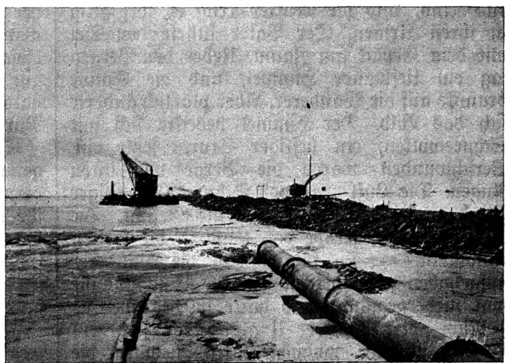
Aufbau des Dammes. Sand und Kies werden aus dem Meer gepumpt.
