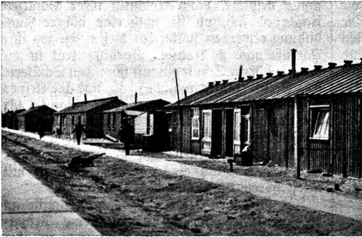
Auf dem 30 km langen Damm finden sich Arbeiteransiedlungen. Der Damm ist unter Wasser 200, über Wasser noch 90 m breit. Er ragt 6–7 m über den Wasserpiegel empor. Eine Bahnlinie, eine Straße und ein Fahrradweg sollen darüber führen.
