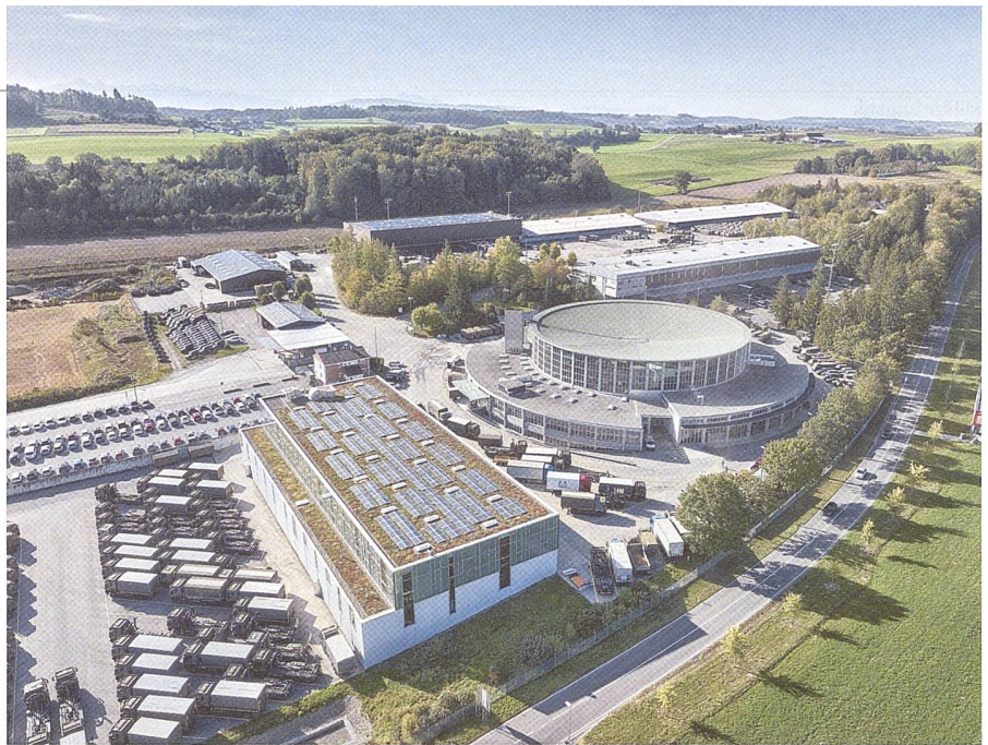
Das Armeelogistikcenter Grolley, eines von insgesamt fünf, oberirdisch und einfach zu finden auf Google Maps.
