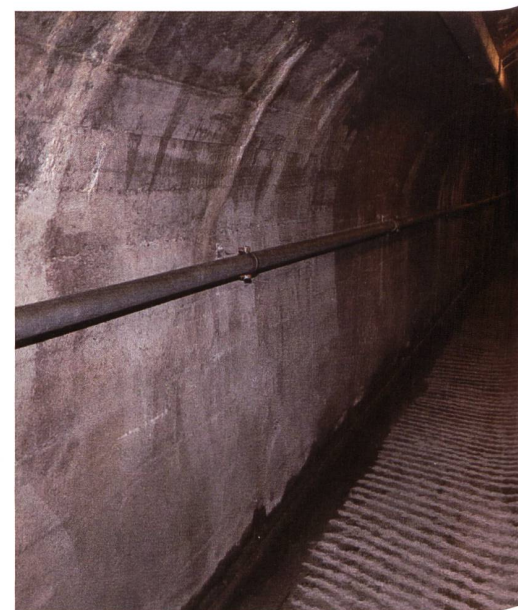
Der Schrägstollen ist 150 m lang. Er überwindet Stockwerken.
