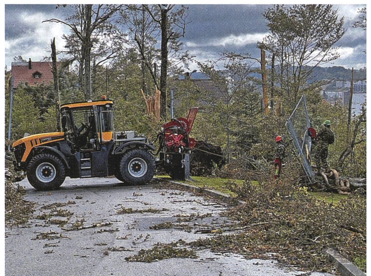
Heftige Gewitterfallböen haben in La Chaux-de-Fonds rund 5000 Häuser beschädigt.
