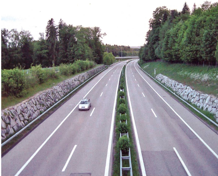
Die Trasse der Autobahn A7 im Raum Oberstücken vor dem Sprengobjekt über das Lippoldswiler Tobel wurde tiefergelegt und die Seitenwände des so entstandenen «Panzergrabens» wurden mit Felsblöcken verkleidet, damit ein seitliches Ausbrechen ins offene Gelände nicht möglich ist.
