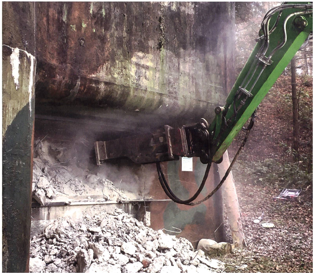
Einige Mitglieder dieses Vereins sind sogenannte Bunkergötti, die viel Zeit und Geld für die Wiederherstellung des originalen Zustands «ihres» Bunkers investieren. Sie vervollständigen auch die Ausrüstung oder müssen sogar zubetonierte Schiessscharten wieder öffnen.
