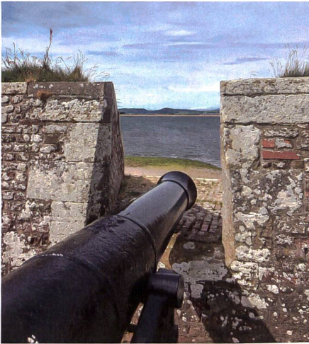
Der Bau der Festung Fort George war ein Prestigeobjekt für den damaligen König Georg II.
