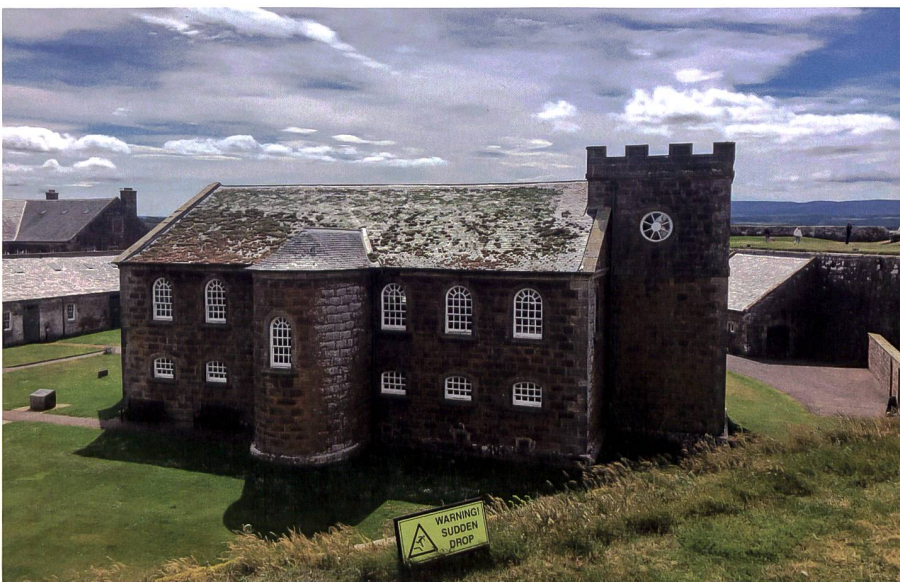
Diese Kapelle wurde 1767 fertig gestellt und befindet sich im nördlichen Teil der Anlage.
