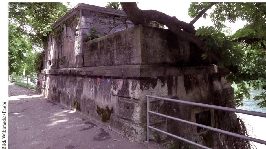
Ein Maschinengewehrstand der Limmatstellung, eingebaut in den historischen Sockel eines einstigen Seiltransmissions-Umlenktores von 1875.
