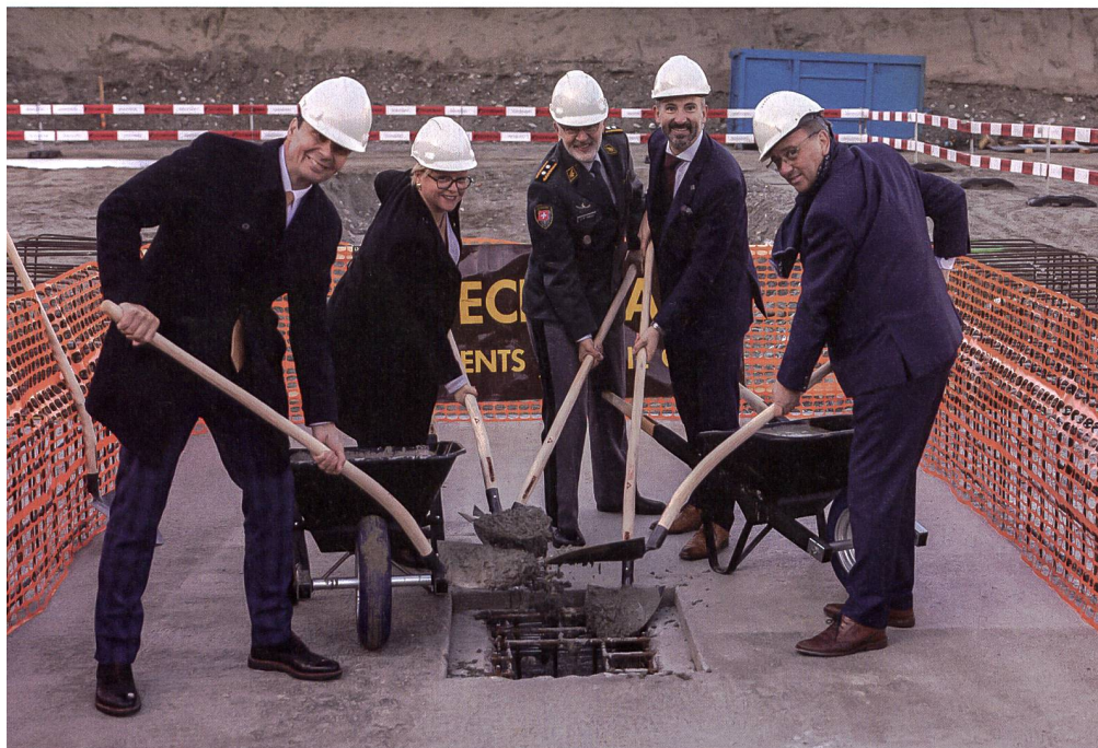
An der offiziellen Zeremonie zum Baubeginn der Indoor-Schiessanlage auf dem Areal der Militärkaserne in Sitten haben Vertreter der Schweizer Armee, des Kantons Wallis und der Stadt Sitten teilgenommen.
