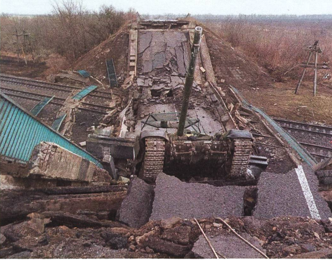
Ein eine zerstörte Eisenbahnbrücke mit Panzerwrack. In den ersten Kriegstagen wurde die Verkehrsinfrastruktur gezielt von beiden Kriegsparteien angegriffen.
