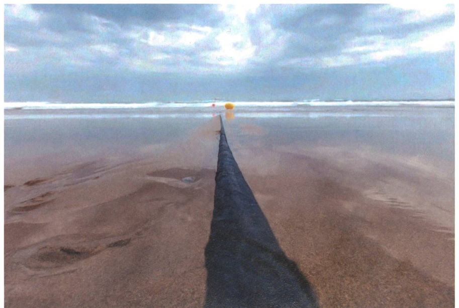
Diese Aufnahme zeigt ein Internetkabel, das ins Meer verlegt worden ist.
