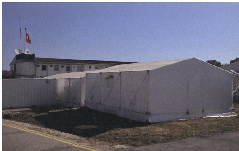
Die Zelte sind in ein bis zwei Tagen aufgebaut, haben einen festen Boden und verfügen sowohl über eine Heizung wie auch eine Klimaanlage.
