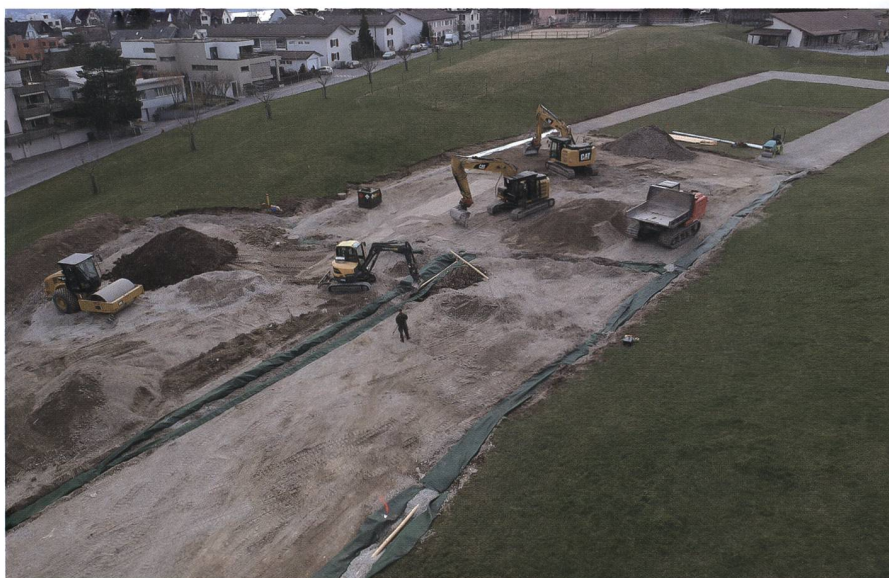
Die Armee baut im Rahmen eines VUM-Einsatzes einen Schotterrasen ein.
