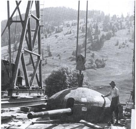
Festung-Abwehrsystem: 1940 bestand es erst ansatzweise. Im Bild: Einbau eines Panzerturms 1941.
