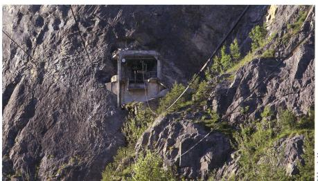
Die Versorgung von Festungen erfolgte auch über Materialseilbahnen direkt ins Werk.
