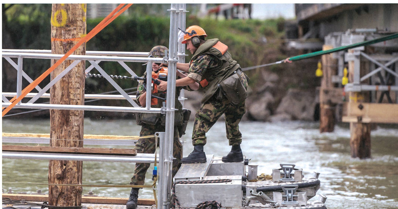
Rammpontoniere beim Bau von Brückenpfeilern.
