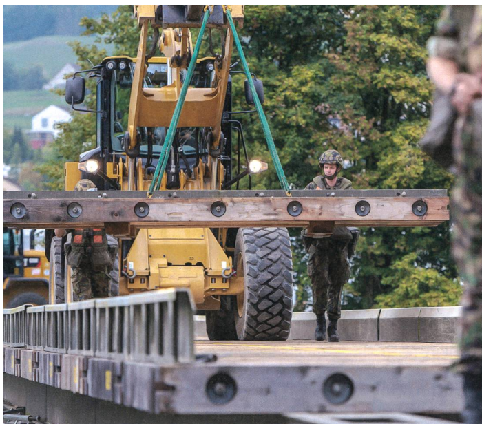
Sappeur beim Bau einer Stahlträgerbrücke.
