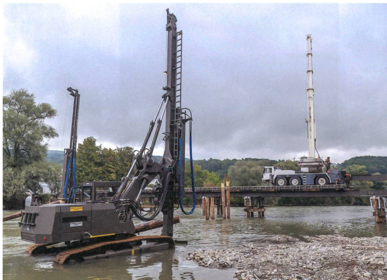
Mit Dieselramme werden die Brückenpfeiler eingesetzt.
