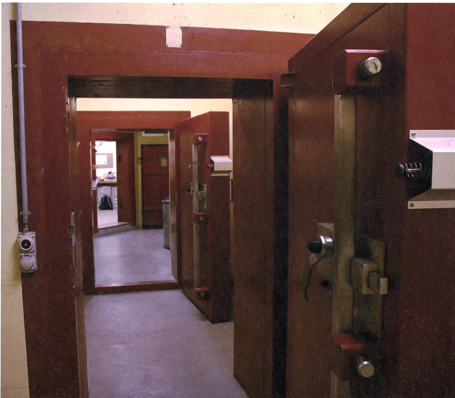
Der Zugang zum Festungsminenwerfer Pila ist hochwertig gesichert: Druckschleuse 3 Atü, Reinigung mit Warmwasserduschen, Gasschleuse mit Schleusenwart.
