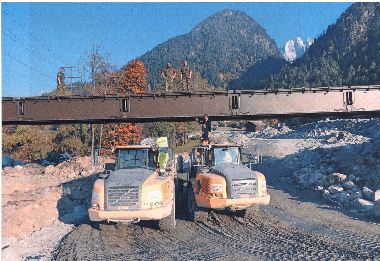
Die Armee baute eine sichere Zufahrt samt der Brücke über die hochfrequentierte Dumperpiste.
