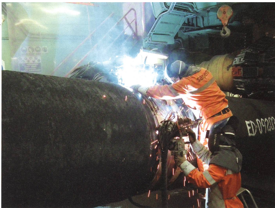
Arbeiter der italienischen Firma Saipem verschweissen Nord-Stream-Rohre.
