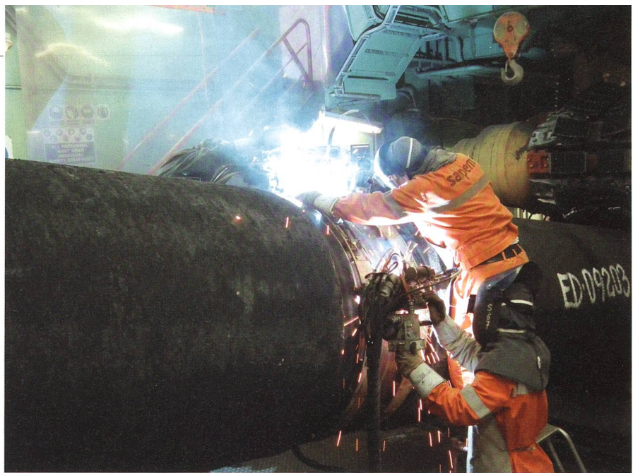
Arbeiter der italienischen Firma Saipem verschweissen Nord-Stream-Rohre.
