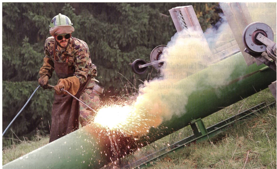
VTU «TECHNICO 16»: Ein Rettungssoldat mit Sauerstofflanze zerlegt einen Mast.
