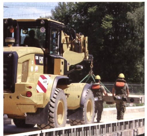
Am Mittwochmorgen bauen die Sappeure die hölzerne Fahrbahn ein.
