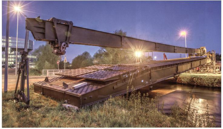
Die 36 Meter lange Unterstützungsbrücke über den Rootkanal.
