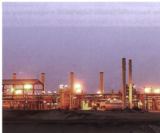
Aufbereitungsanlage bei der Oase Jakhira.
