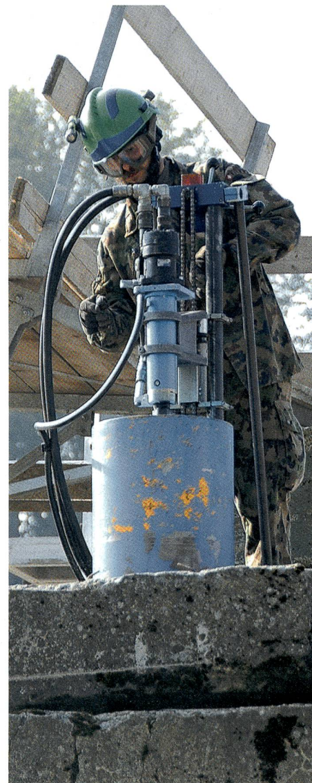
Kernbohrgerät im harten Betoneinsatz.
