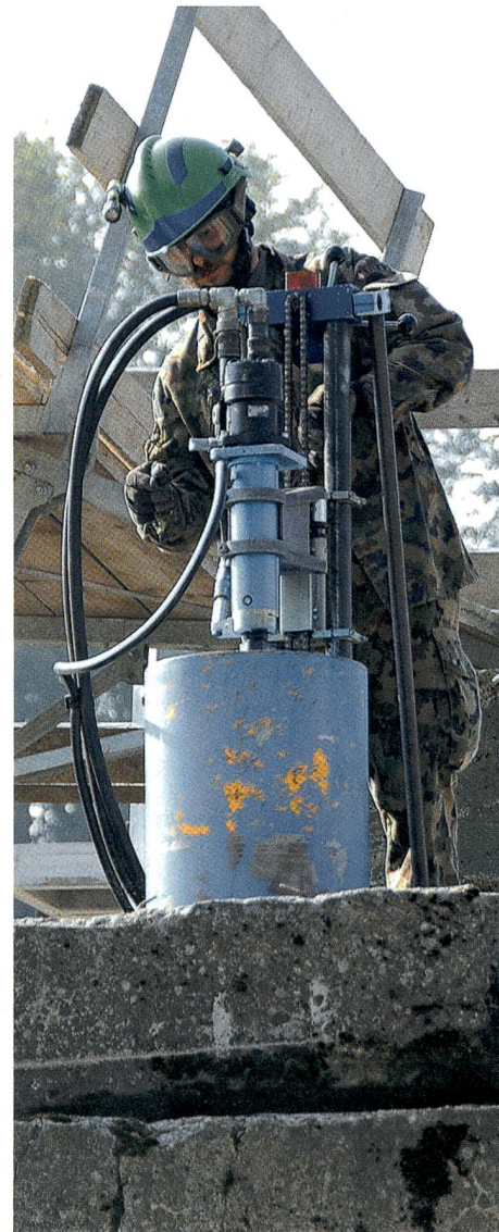
Kernbohrgerät im harten Betoneinsatz.
