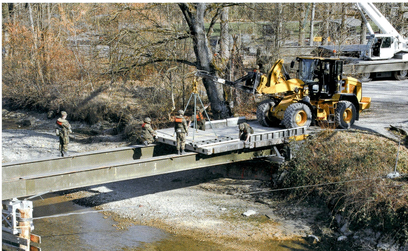
Im Vorfeld ausgeführte Rammarbeiten und die Stahlträgerbrücke waren ganz aus der Nähe zu sehen.
