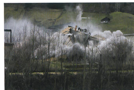
Mit je 30 Millisekunden Zeitverzögerung fallen die vier Hausseiten exakt nacheinander zusammen – exakt wie berechnet.
