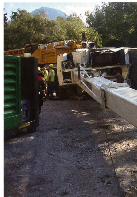
Der Ausleger wird demontiert.
