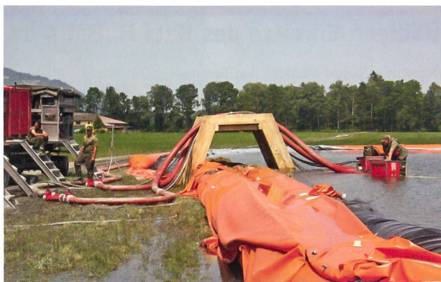
Das riesige Entlastungsbecken fasst 300 000 Liter. Es fängt Abwasser auf, bindet dieses und leitet es in den Rhein weiter.
