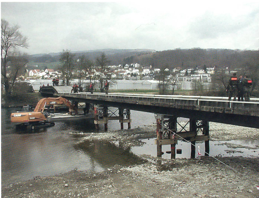
Stahlträgerbrücke (Eggenwil, Bremgarten AG).
