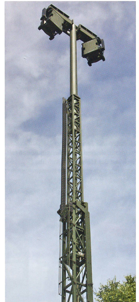
Der Kommunikationspanzer hat den Mast aufgerichtet. Oben Richtstrahlgeräte R-905, gerichtet auf das Relais, von dem die Verbindung über den Knoten ins IMFS (Integriertes Militärisches Fernmeldesystem) führt. IMFS-Standort geheim.
