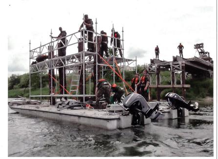
Amlikon: Soldaten des Katastrophenhilfebatallons 4 bauen eine behelfsmässige Brücke über die Thur. Die Tragkraft der Brücke beträgt stolze 70 Tonnen.
