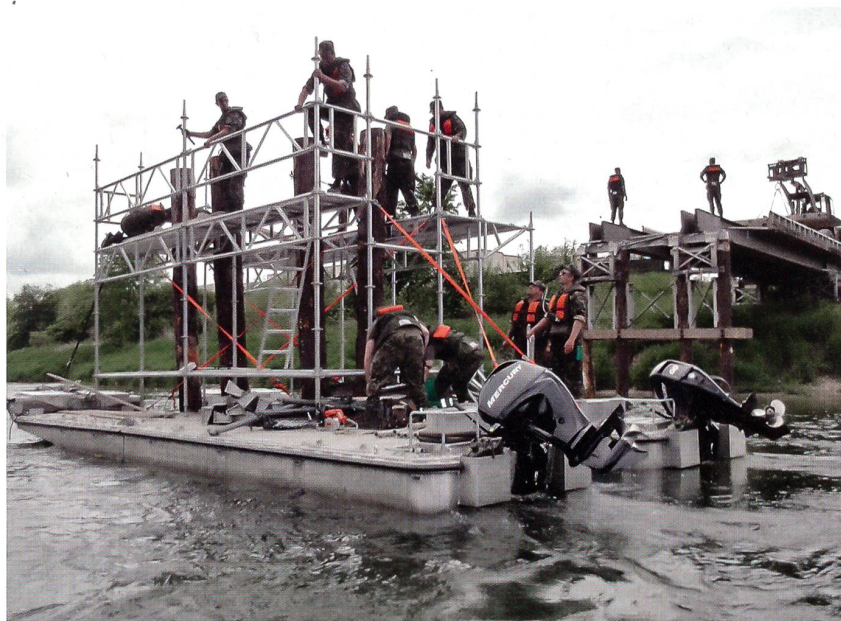
Amlikon: Soldaten des Katastrophenhilfebataillons 4 bauen eine behelfsmässige Brücke über die Thur. Die Tragtaktik der Brücke beträgt stolze 70 Tonnen.
