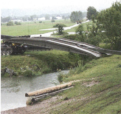
Die Brücke über den Kanal ist gelegt.
