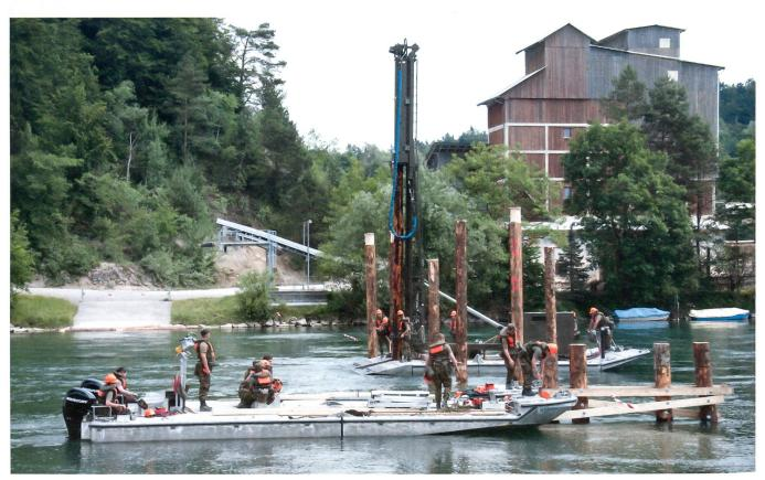
Um die Pfähle für die Pfeiler zu setzen, verwenden die Genisten eine Ramme.
