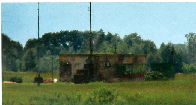
Gut getarnt: Der Tower des Militärflugplatzes Smolensk ist eine Baracke, rund 80 Meter von der Landebahn entfernt. Von hier hielt der russische Cheffluglotse, Oberst Pawel Pljusin, selber ein Pilot, Funkverbindung zur polnischen Maschine.
